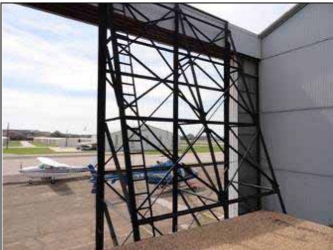
29. Hangar door gantry framing
